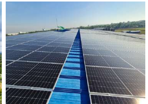
미안마 법인 태양광 설치 모습
