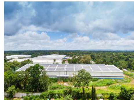
니카라과 법인 태양광 설치 모습
